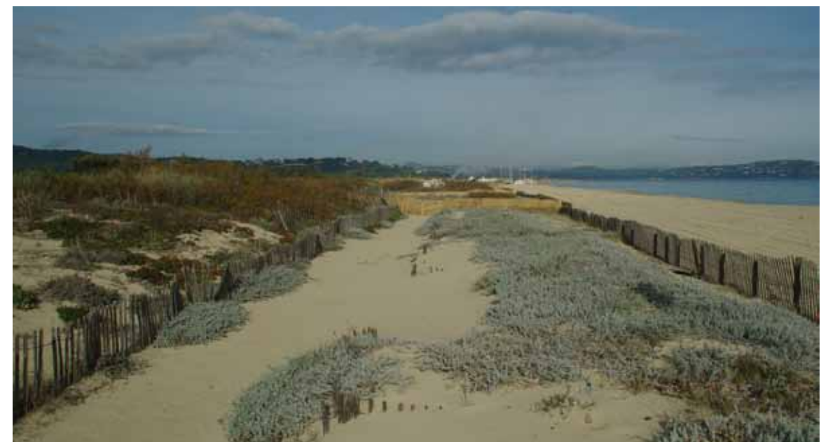
Un cordon dunaire à conforter sur l'ensemble de la plage
