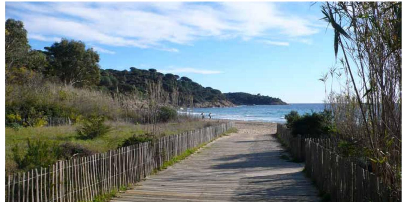
Référence pour les accès véhicules : platelage en bois avec «poutres» posées bord à bord.
