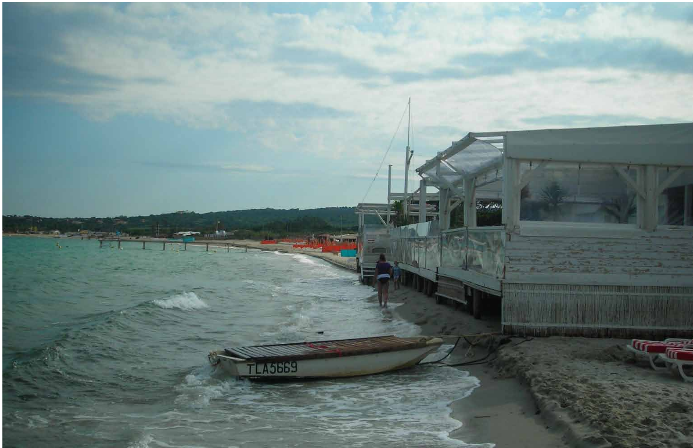
Sur ce cliché de 2008, il apparaît clairement que l'érosion de la plage, dans le secteur Nord, est telle que certains bâtiments ont les pieds dans l'eau, avec, pour conséquence, des dégradations matérielles et une limitation de l'accès au Domaine Public Maritime (source : Groupement ALEP).
