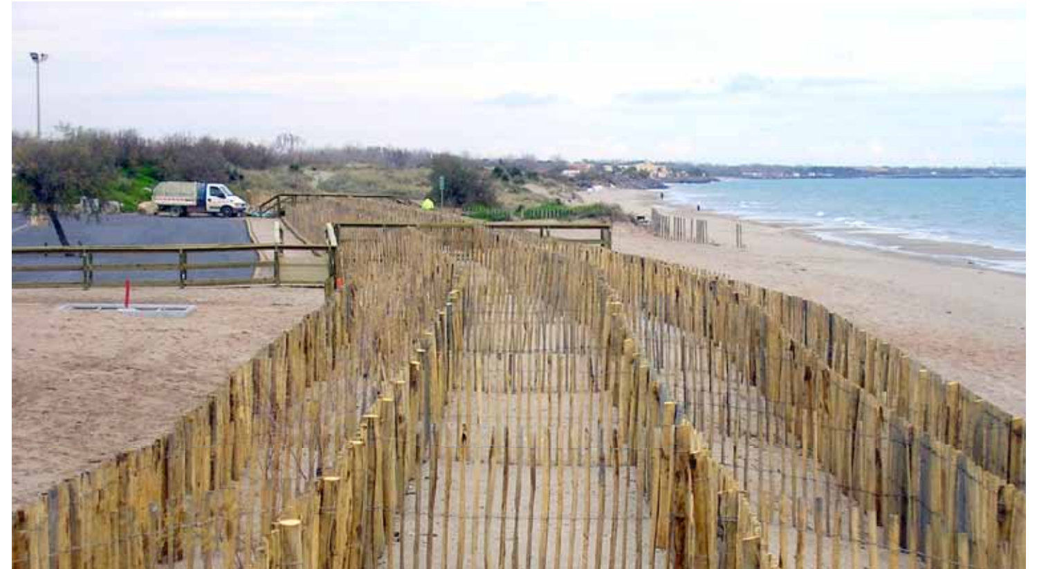
Plage de la Redoute - après travaux
