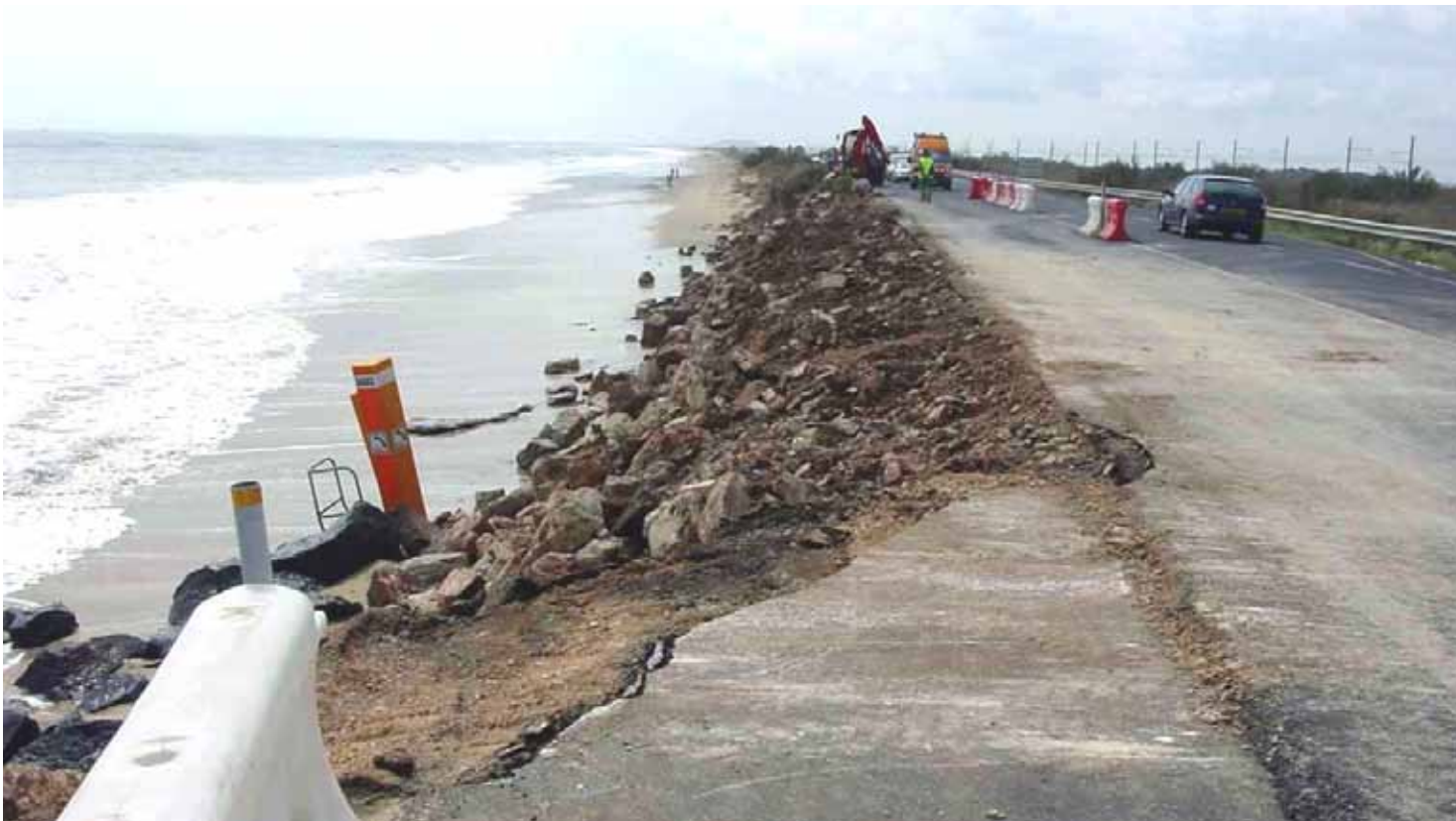
Plage du Lido - avant travaux
