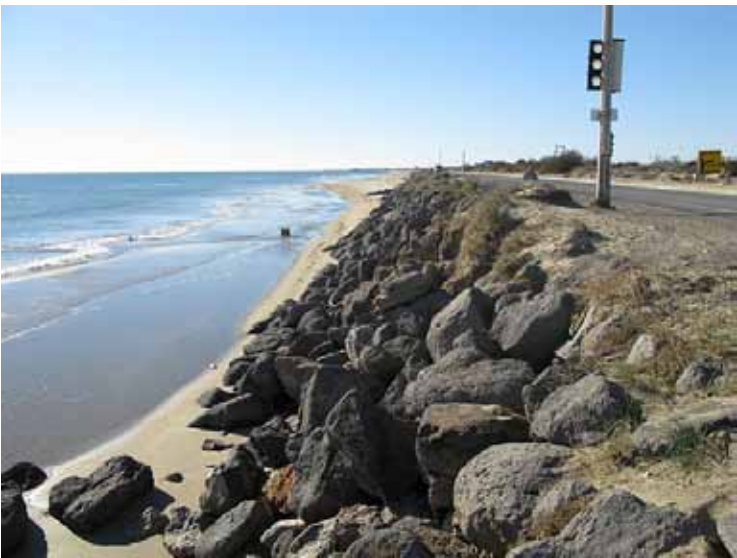
Secteur ouest non restauré
