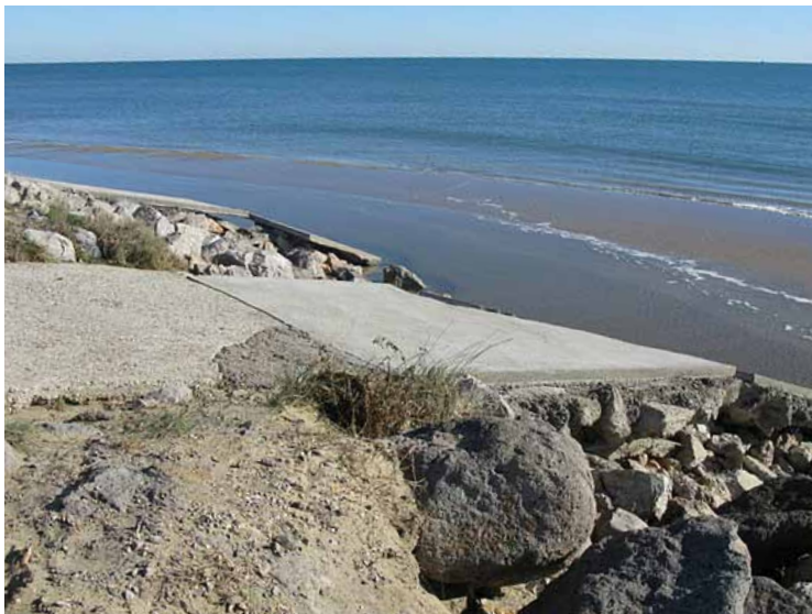
Secteur ouest non restauré
