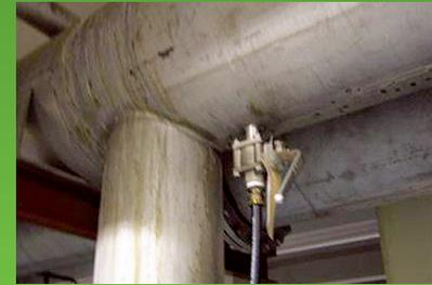
**Après :** Modification du point de prélèvement et passage d'un point bas (risque colmatage élevé) à un point haut sans risque, en inversant l'aspiration et le refoulement.
