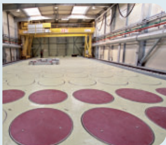
Puits pour l'entreposage de déchets moyennement radioactifs
