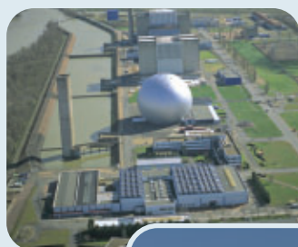
Chinon : centrale de génération 1
