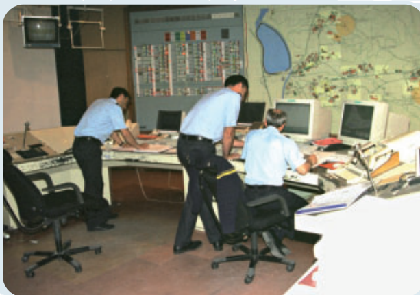
Télesurveillance du site
