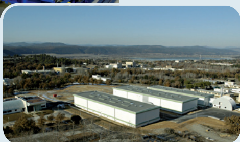
CEDRA : entreposage de colis de déchets
