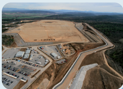
Une plateforme de 40 hectares a été aménagée pour accueillir l'installation
