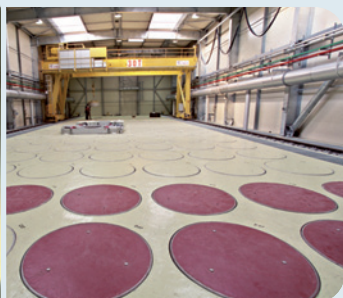
Puits pour l'entreposage de déchets moyennement radioactifs
