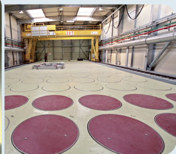
Puits pour l'entreposage de déchets moyennement radioactifs
