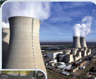
Dampierre-en-Burly : centrale de génération 2
