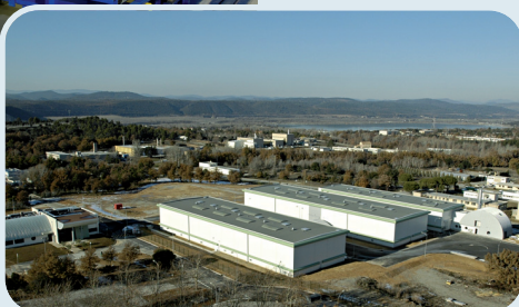
CEDRA : entreposage de colis de déchets
